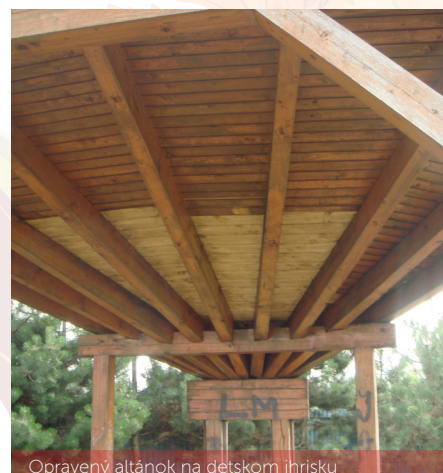
Opravený altánok na detskom ihrisku
