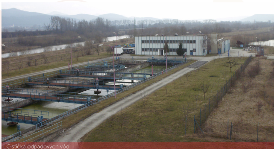
Čistička odpadových vôd
