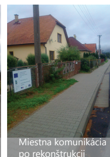
Miestna komunikácia pred rekonštrukciou
